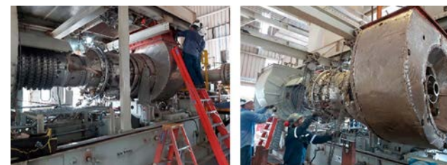
Figura 19 – Substituição da turbina A da Estação de Compressão de Corumbá/MS
