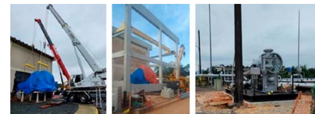
Figura 24 – Retirada do motocompressor de Araucária/PR, montagem da casa e instalação do filtro em Biguaçu/SC
