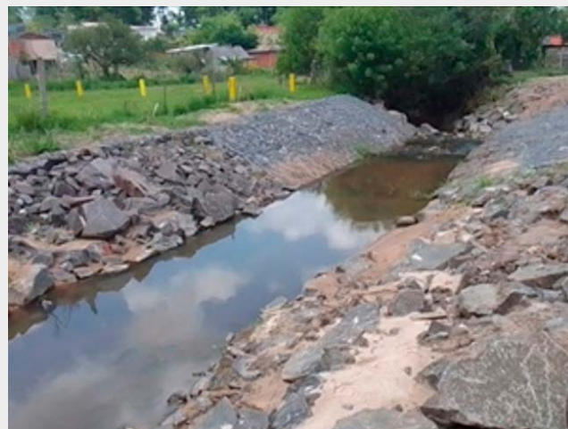
Figura 16 – Reparo de travessia de rio
