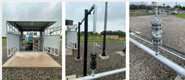
Figura 12 – Instalação do cromatógrafo de Joinville
