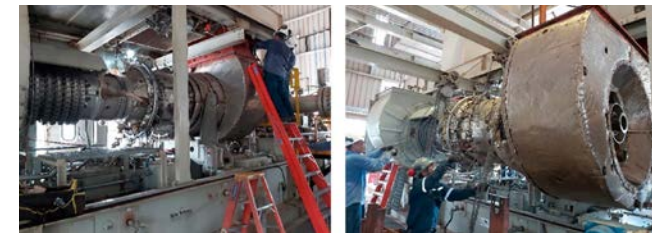
Figura 19 – Substituição da turbina A da Estação de Compressão de Corumbá/MS
