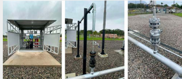
Figura 12 – Instalação do cromatógrafo de Joinville
