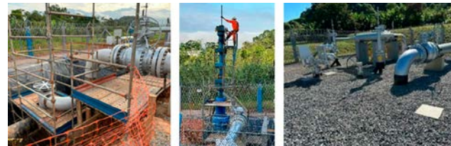
Figura 22 – Serviço de trepanação
