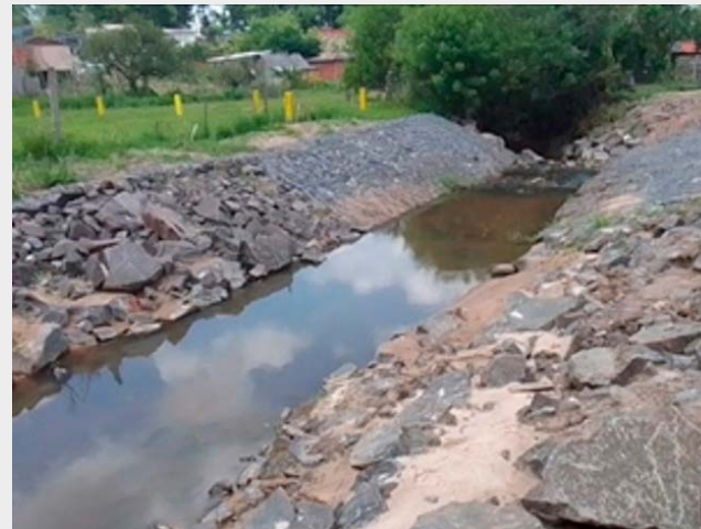
Figura 16 – Reparo de travessia de rio
