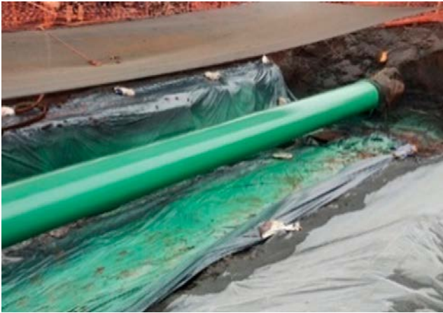
Figura 14 – Aplicação do revestimento na Estação de Compressão de Campo Grande/MS
