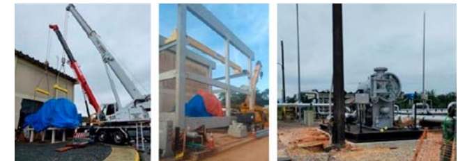
Figura 24 – Retirada do motocompressor de Araucária/PR, montagem da casa e instalação do filtro em Biguaçu/SC
