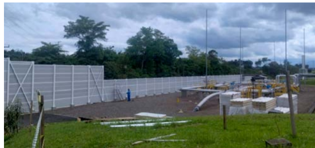
Figura 23 – Instalação da barreira acústica na Estação de Compressão de Siderópolis/SC
