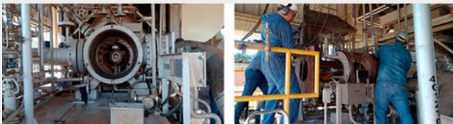
Figura 20 – Substituição do bundle do compressor da Estação de Compressão de Penápolis/SP
