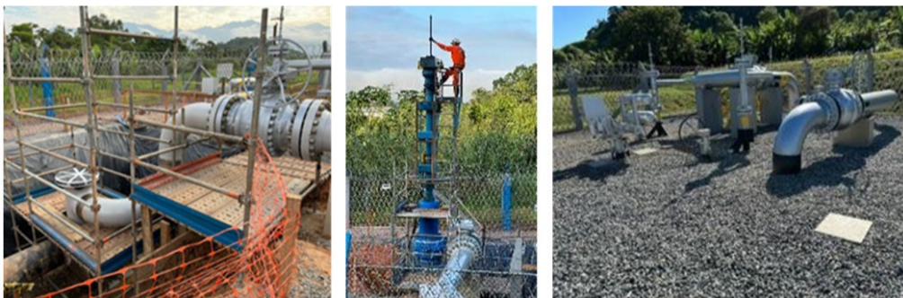
Figura 27 – Serviço de trepanação
