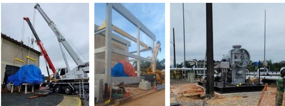
Figura 29 – Retirada do motocompressor de Araucária/PR, montagem da casa e instalação do filtro em Biguaçu/SC
