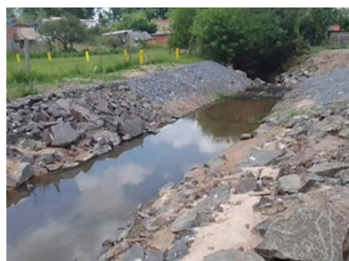
Figura 21 – Reparo de travessia de rio
