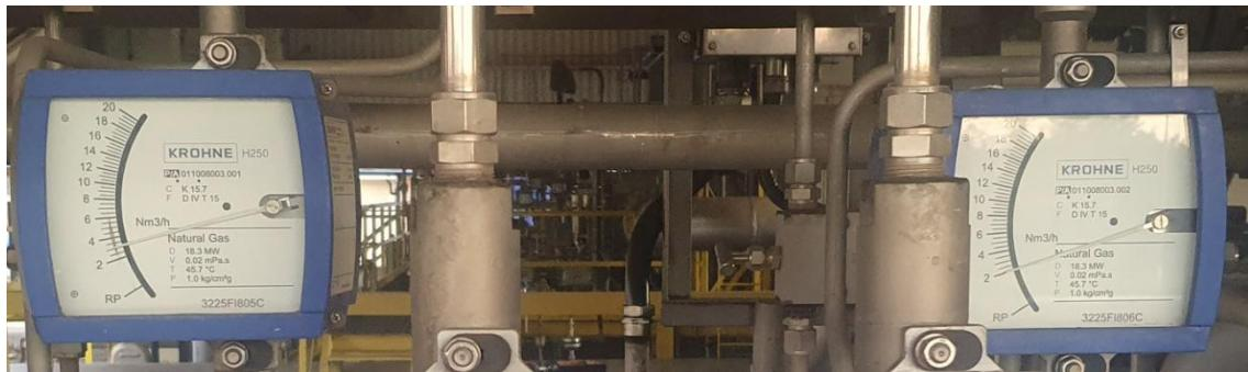
Figura 1 – Medidores de vazão de liberação de gás natural do sistema de selagem da Ecomp.
