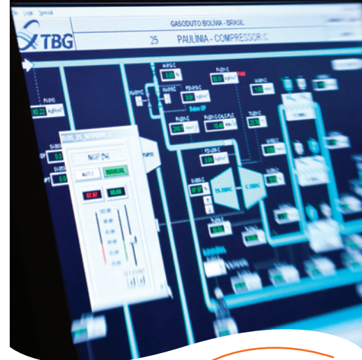
TELA DO SISTEMA DE SUPERVISÃO, CONTROLE E AQUISIÇÃO DE DADOS
