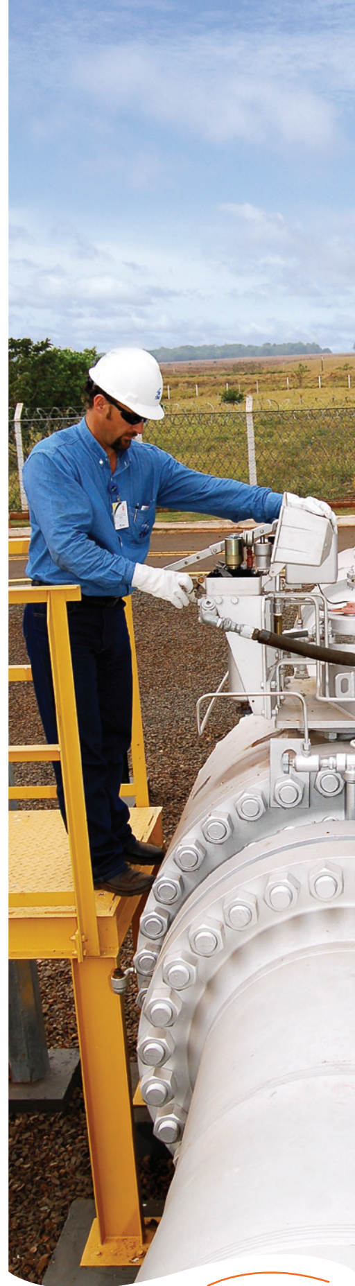
TÉCNICO EM INSTALAÇÃO DE CAMPO GRANDE/MS
