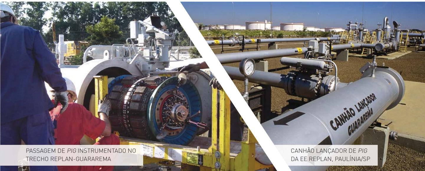
PASSAGEM DE PIG INSTRUMENTADO NO TRECHO REPLAN-GUARAREMA
