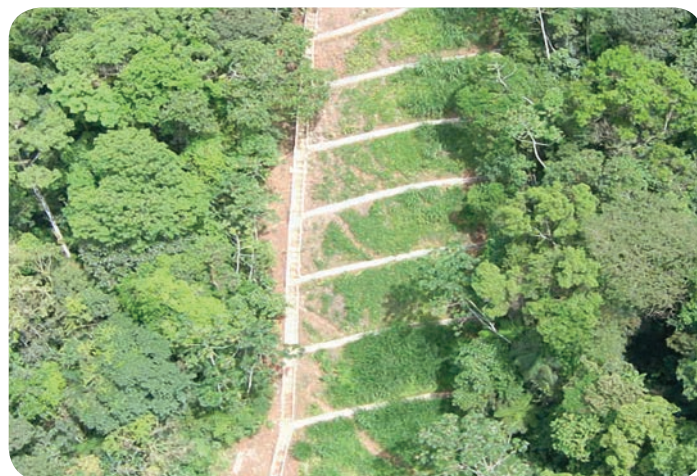
Sistema de drenagem na faixa do gasoduto
