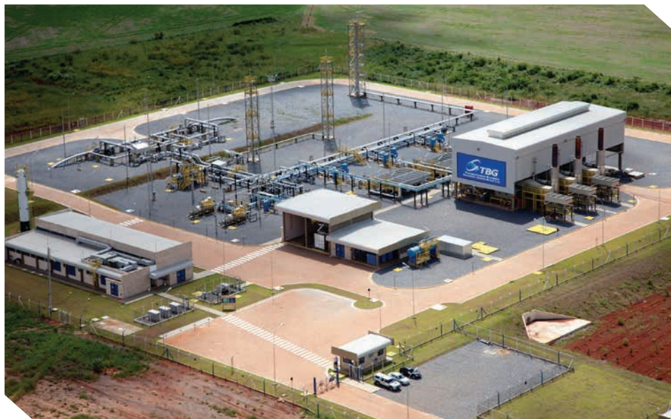
Estação de Compressão de Capão Bonito/SP
