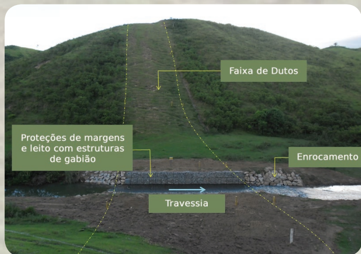
Travessia com intervenções para contenção da erosão. Aos poucos, a vegetação irá se recompor no entorno.
