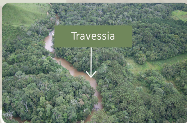
Travessia do duto em área com mata ciliar preservada.
